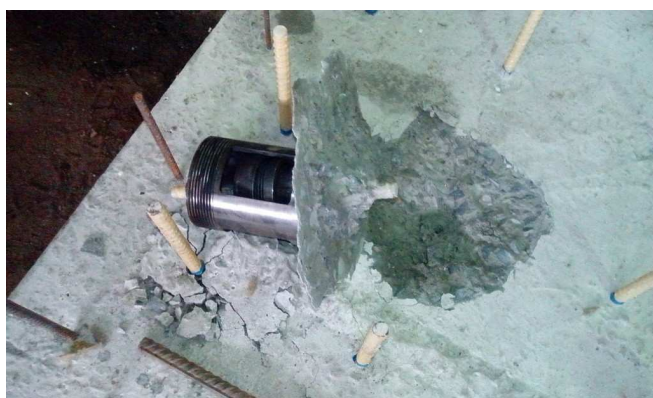
Рисунок 4 – характер разрушения узла сцепления СППС и бетона
