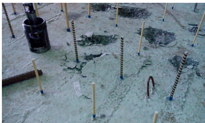
Рисунок 6 – вид плиты в процессе проведения испытаний
